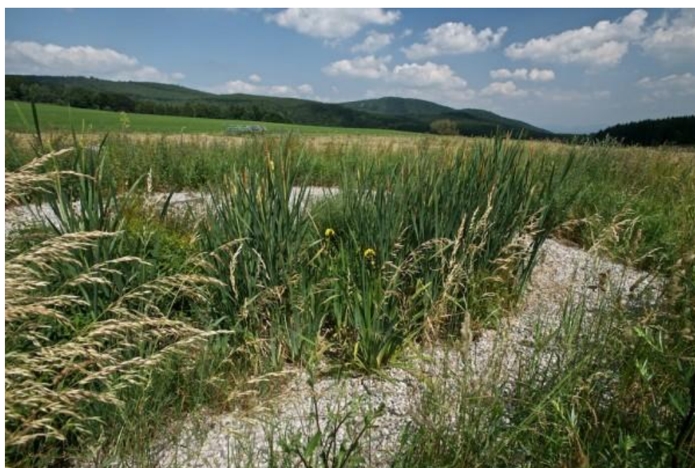
Obrázek 35 - Pohled na KČOV Boleboř ( http://www.korenova-cisticka.cz/ )
