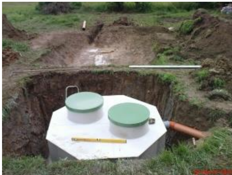
Obrázek 32 - Stavební práce na KČOV - ukládání biologického septiku ( http://www.zelenestaveni.cz/ )
