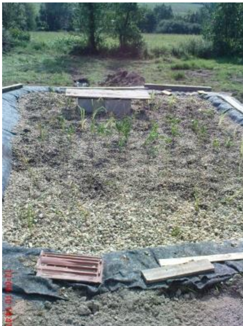
Obrázek 33 Stavební práce na KČOV - výstavba kořenového pole ( http://www.zelenestaveni.cz/ )
