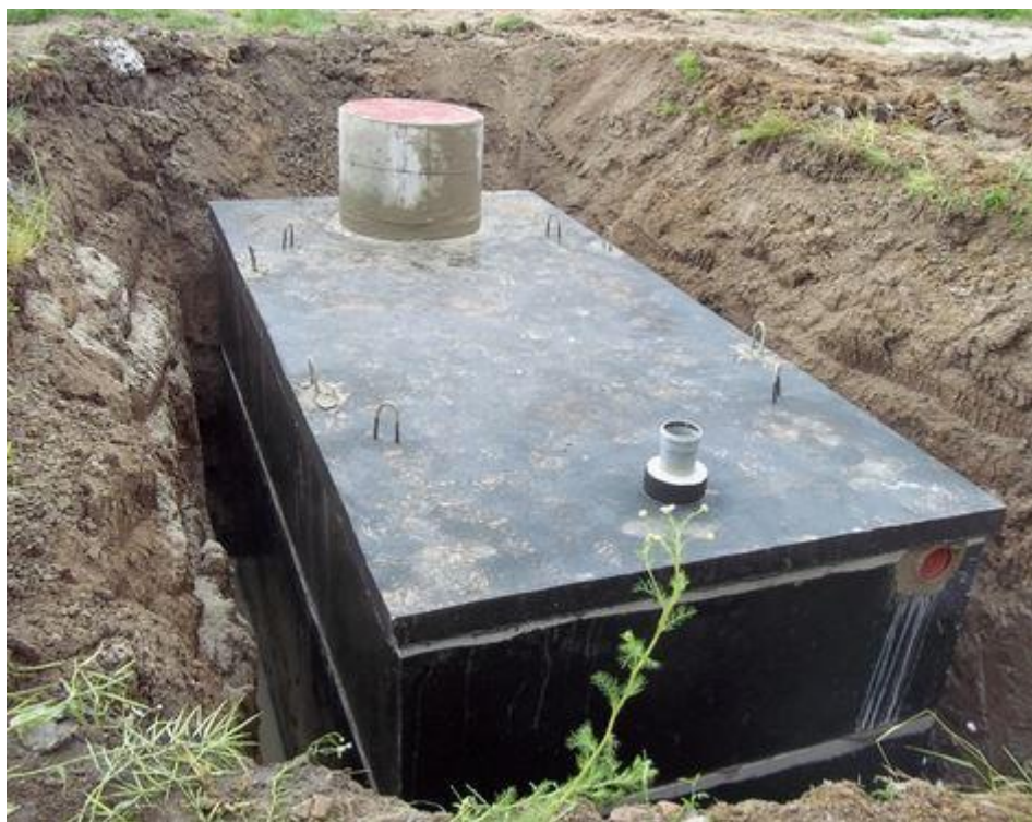
Obrázek 15 - Ukládání jímky do země ( www.asio.cz )
