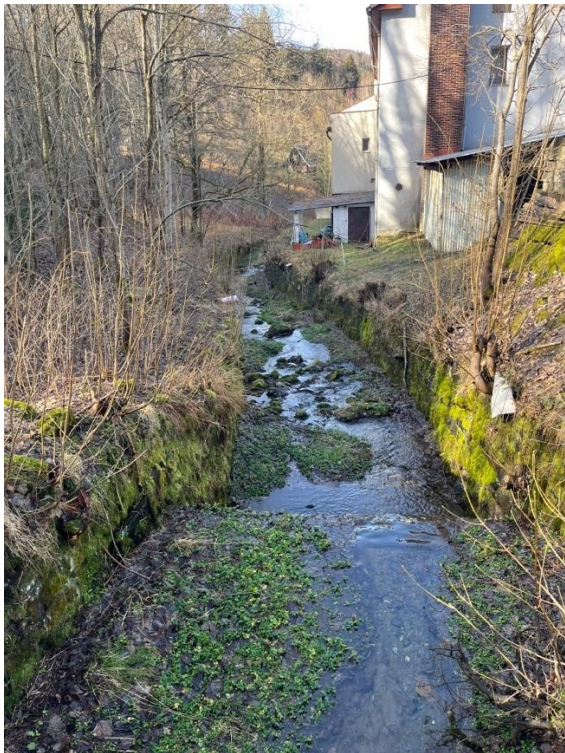
Obrázek 22 – Koryto obdélníkového profilu, nánosy sedimentu (zdroj: Florián Felbaba, 2024)
