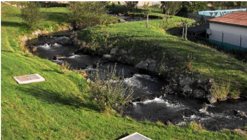
Rybí přechod 1 – příklad RP typu přírodního obtokového koryta (bypassu; autor: Ing. David Bůžek).
