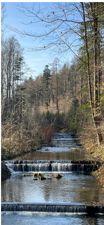
Obrázek 20 - Pohled na úsek č. 9 (zdroj: Florián Felbaba, 2024)
