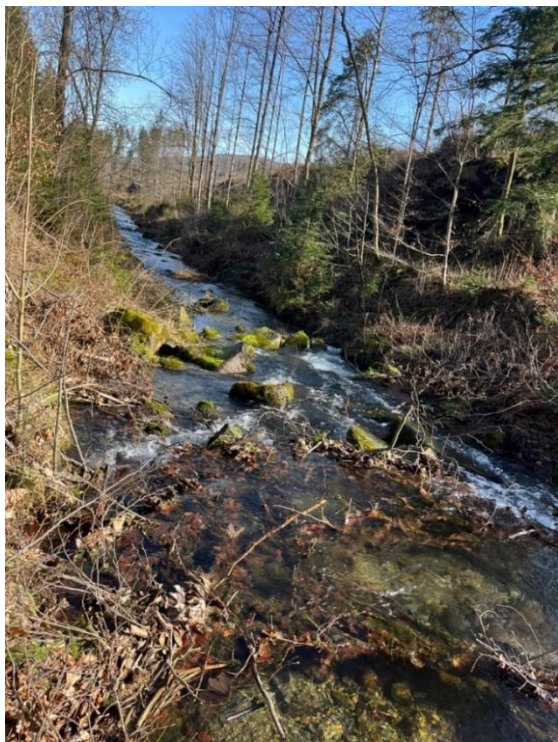
Obrázek 19 - Akumulace naplaveného dřeva v úseku č. 9 (zdroj: Florián Felbaba, 2024)
