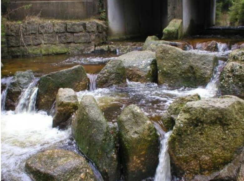
4 – příklad migračně propustného balvanitého skluzu (autor: Ing. Kamil Farský – AOPK ČR).
