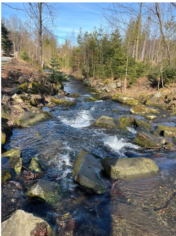
Obrázek 17 - balvanitý skluz (zdroj: Florián Felbaba, 2024)
