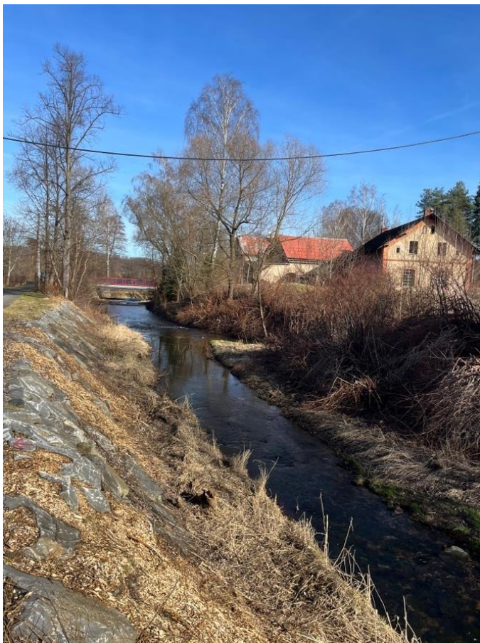
Obrázek 6 - Pohled na úsek č.1 (zdroj: Florián Felbaba, 2024)
