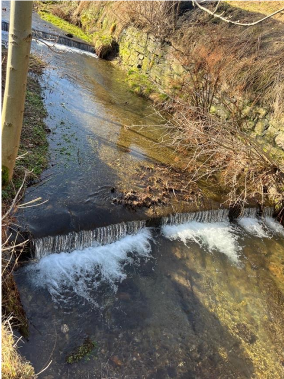
Obrázek 21 - Obdélníkový profil, břehy jsou souvisle opevněny zdmi. (zdroj: Florián Felbaba, 2024)
