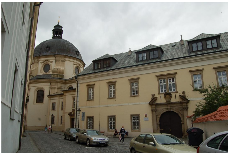
Příloha č. 4: Budova piaristické koleje (foto vlastní)
