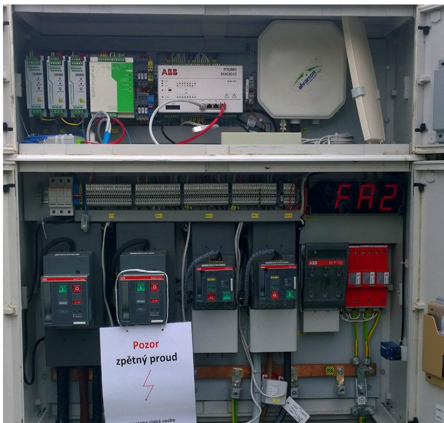
Obr. 10 Rozpojovací skříň nn Zdroj: Skupina ČEZ
