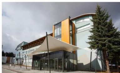
Budova NA – budova děkanátu
