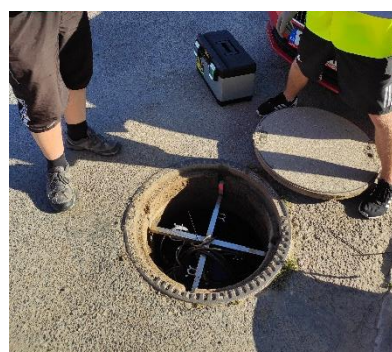
Obr. 3. 9. Osazení držáku na bateriový modul (foto: autor)
