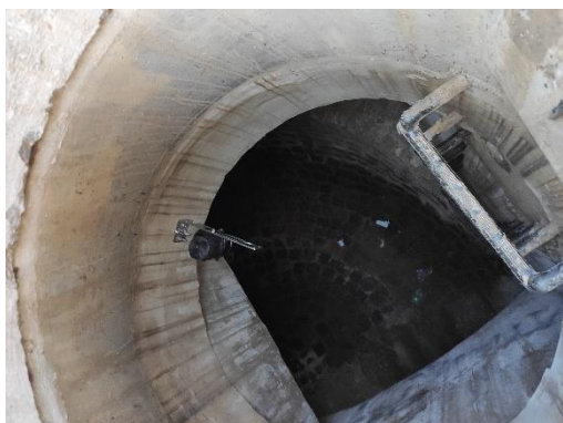
Obr. 3. 19. Osazení hladinoměru na OK (foto: autor)
