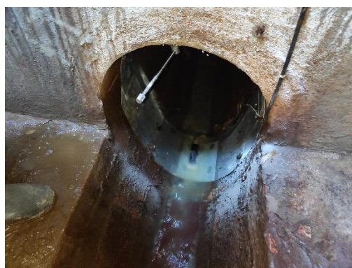
Obr. 3. 11. Osazený AV senzor ve stoce (foto: autor)
