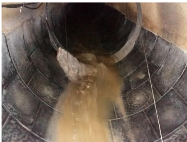
Obr. 3. 13. Zanesení AV senzoru (foto: Jakub Lžičař)
