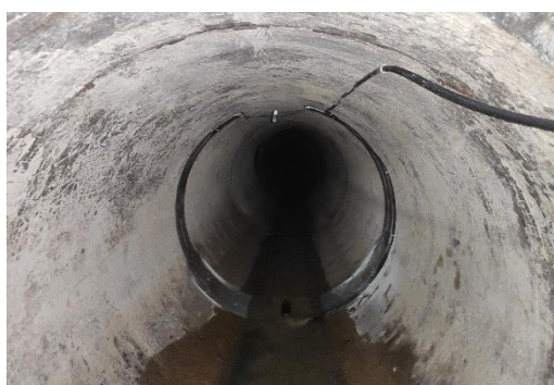
Obr. 3. 10. Osazený AV senzor ve stoce (foto: autor)
