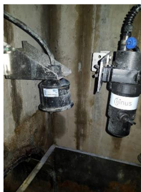
Obr. 3. 18. Osazení hladinoměrů ISCO a IJINUS (foto: Jakub Lžičář)
