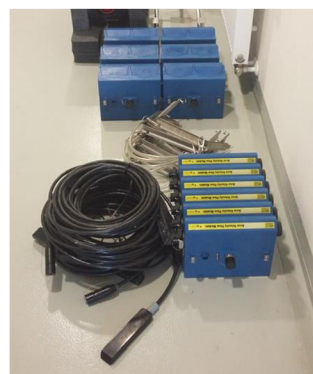
Obr. 3. 7. Příprava na instalaci průtokoměrů (foto: Jakub Lžičar)
