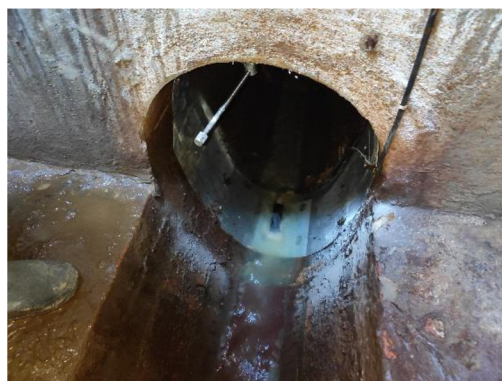
Obr. 3. 11. Osazený AV senzor ve stoce (foto: autor)
