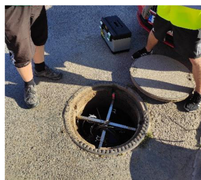
Obr. 3. 9. Osazení držáku na bateriový modul (foto: autor)
