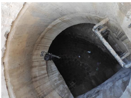
Obr. 3. 19. Osazení hladinoměru na OK (foto: autor)
