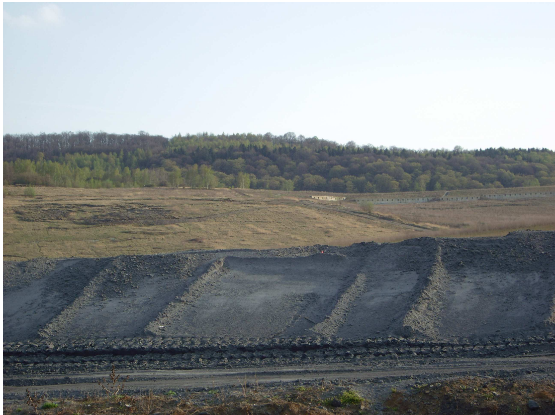
Obr. č. 21 Stabilizační práce na svahu Rabenov. Zdroj: autor
