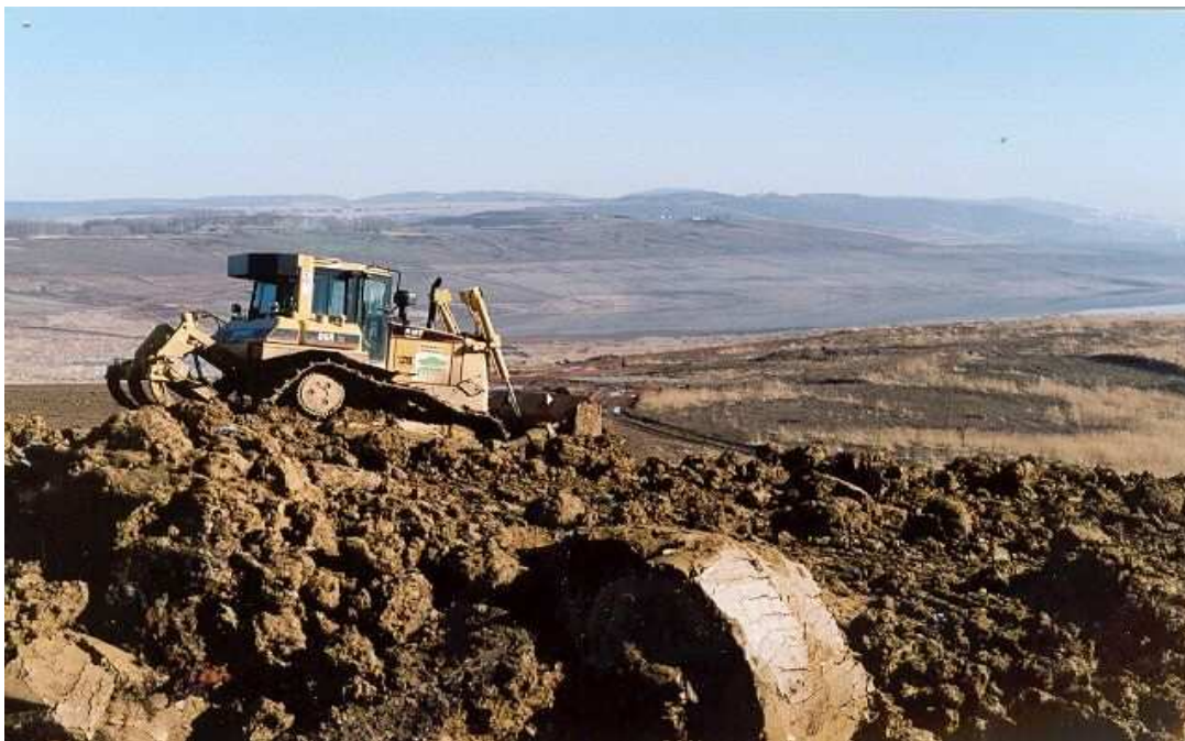
Obr. č. 2 Technické práce. Zdroj: PKÚ
