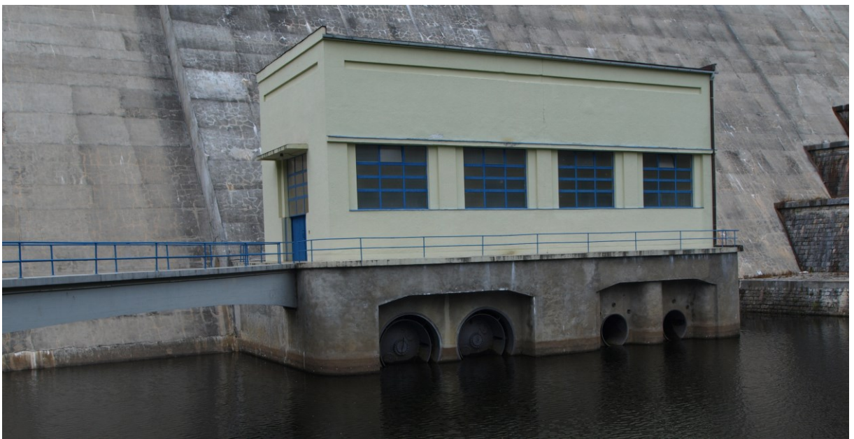
obr. 1.2 Dvojice prstencových uzávěrů DN 1600 na levé straně strojovny spodních výpustí VD Vranov
