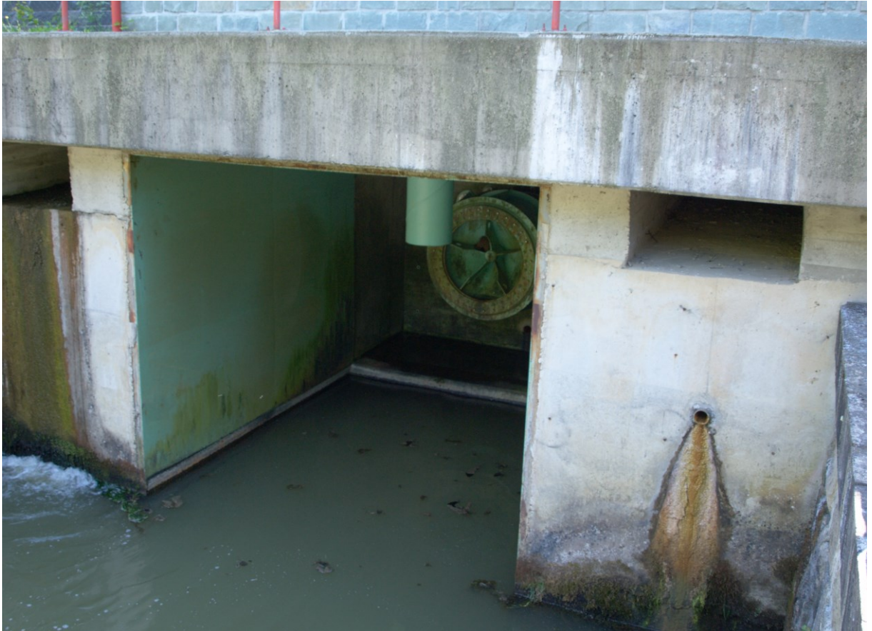
obr. 1.5 RU v opancěřované výtokové komoře na VD Bystřička
