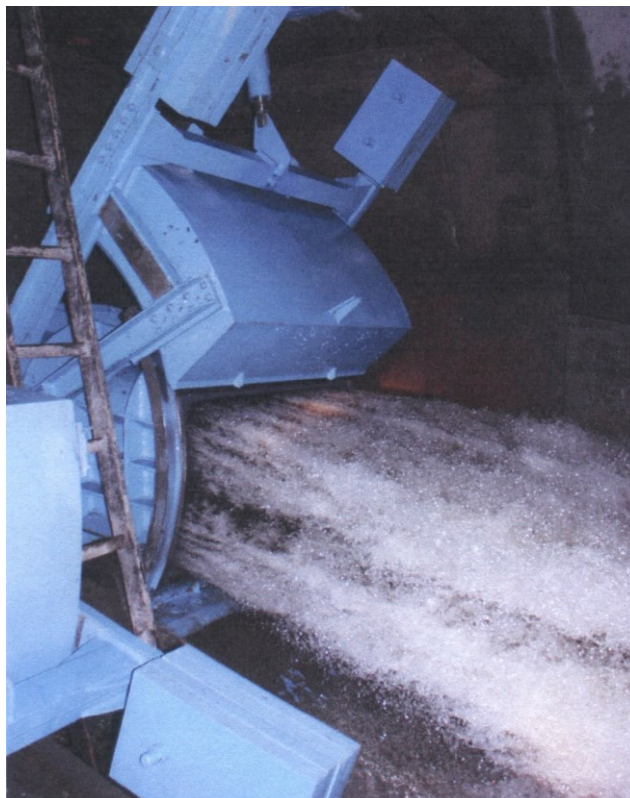
obr. 1.4 Spodní výpust DN 1000 na VD Souš se segmentovým uzávěrem, zdroj: archiv J. Šulce
