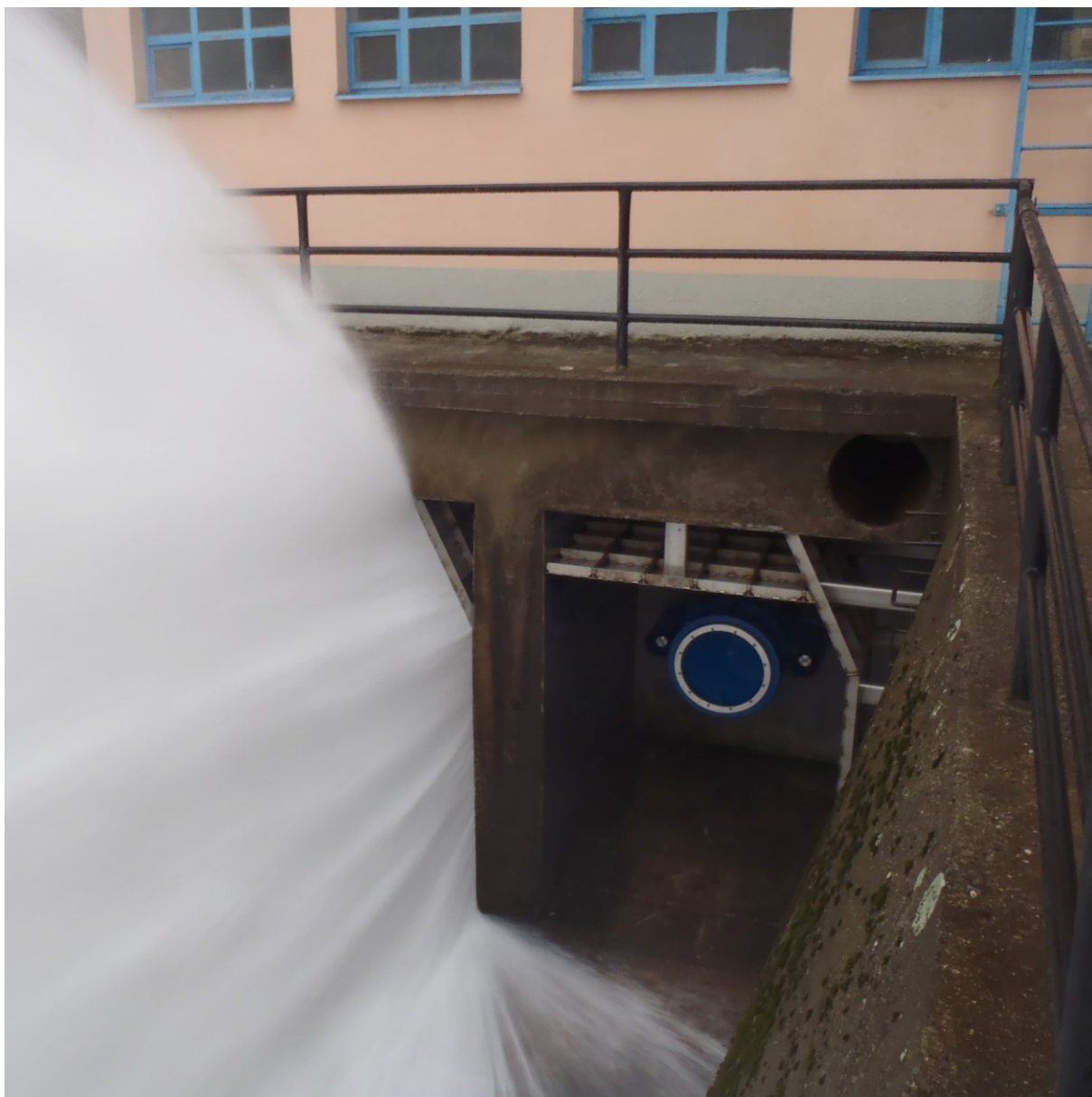
obr. 3.9 Úprava výtokové komory na VD Vrchlice vynucená výměnou RU, zdroj: archiv Povodí Labe, s. p.
