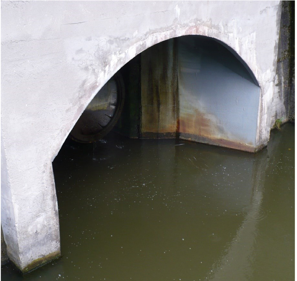
obr. 3.8 Tvar výtokové komory na VD Hřiňová, zdroj: archiv Jana Šulce
