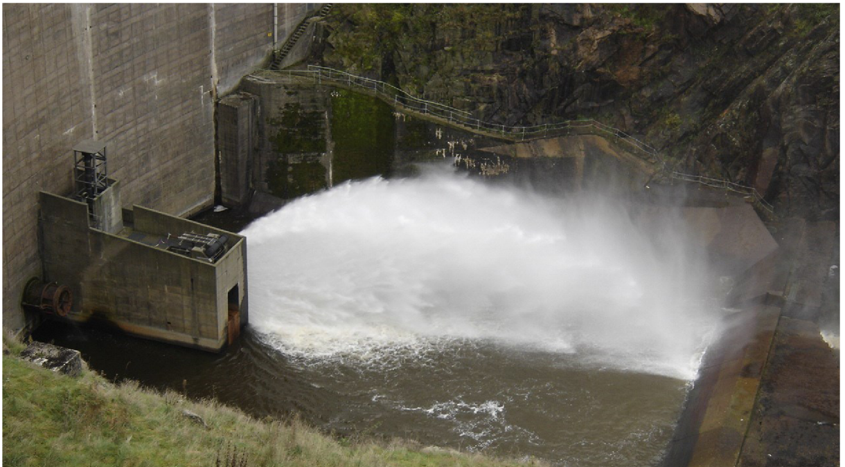
obr. 1.7 Šíření vodní tříště při výtoku z RU do volna na vzdušném líci betonové hráze, zdroj: [23]
