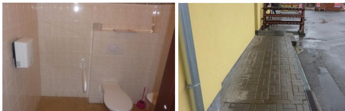
Obrázek 39, 40. Bezbariérové WC a příjezdová rampa.
