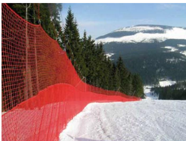
Obrázek 17. Příklad zajištění nebezpečné oblasti pomocí A-FIS sítě (Jurdík et al., 2007).
