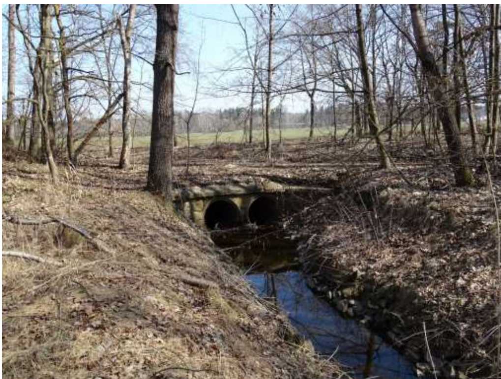
Fotografie č. 15 Místo, kde vytéká rybníční voda z uměle vybudovaného kanálu při severním okraji jezera Horusice I do Lužnice
