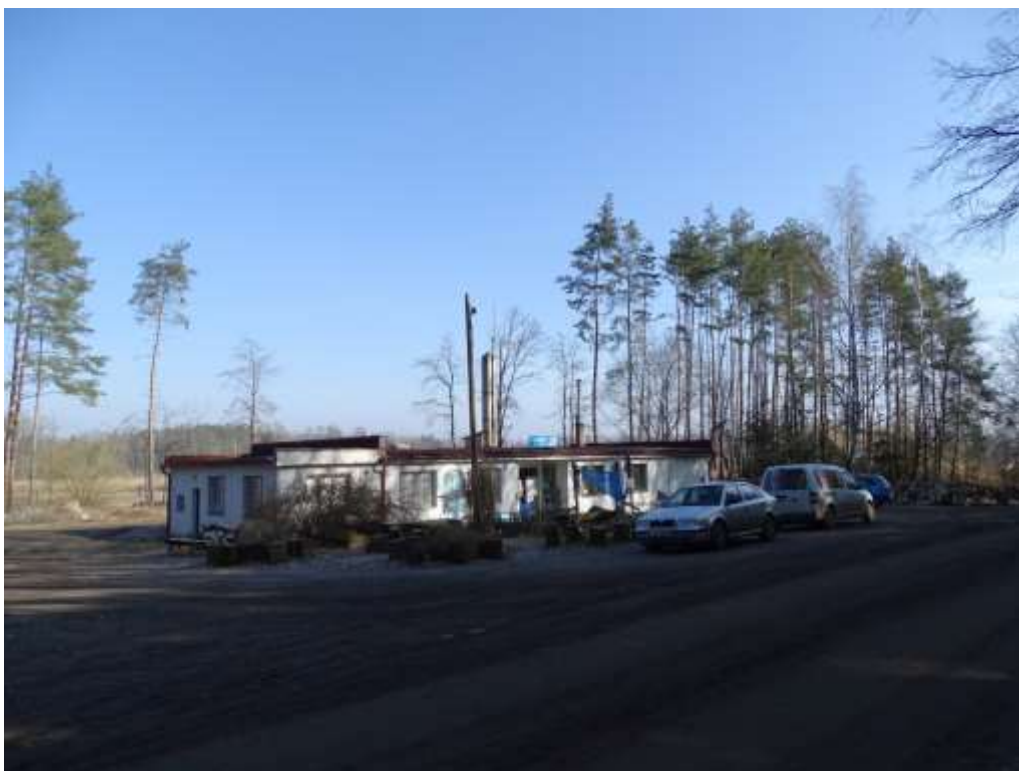
Fotografie č. 5 Bývalá budova sociálního zařízení pro těžebnu Horusice, podniková zkušebna kameniva a dnes občerstvení „Pod Hrází“
