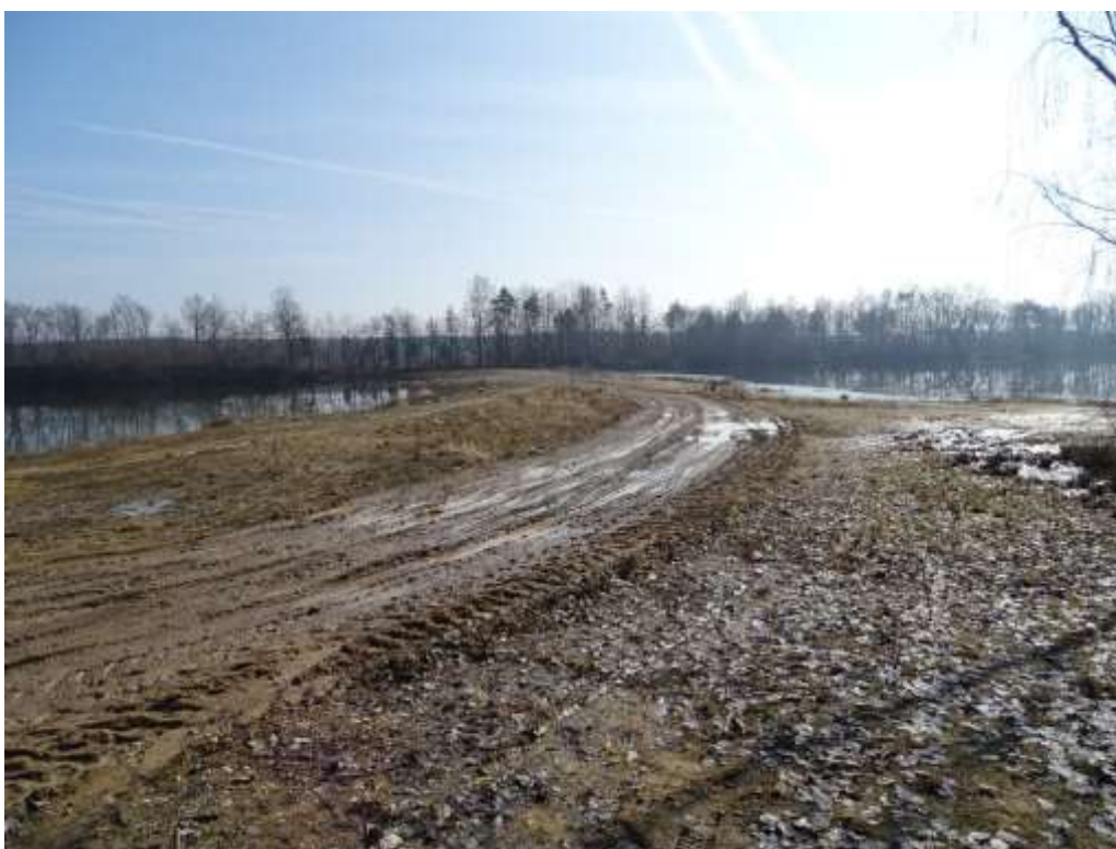
Fotografie č. 8 Nový přesyp, kterým bylo v roce 2018 rozděleno jezero Horusice na jezera Horusice – sever a Horusice – jih. Pohled od západu
