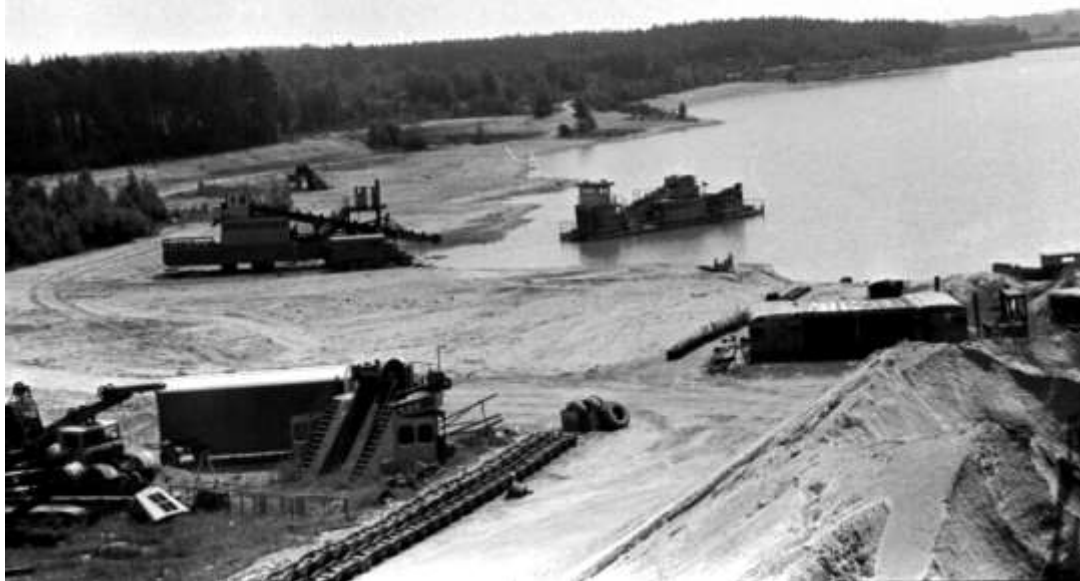
Fotografie č. 51 Historický snímek poskytnutý BS Cost s.r.o. Severní uzávěr velké vlkovské pískovny. Místo deponování natěžené suroviny a následné úpravy tříděním. 1978
