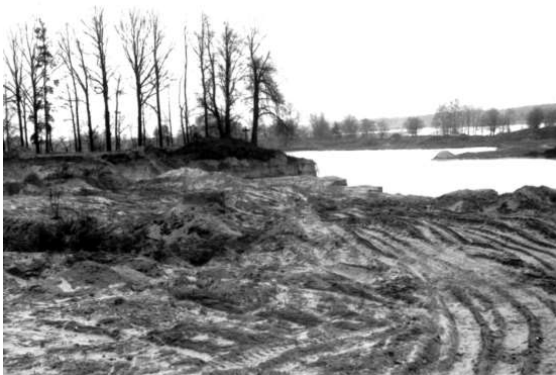
Fotografie č. 52 Historický snímek poskytnutý BS Cost s.r.o. Těžba v jezeře v dnešním jezeře Horusice – jih. Na snímku je patrné místo U Křížku. 1979
