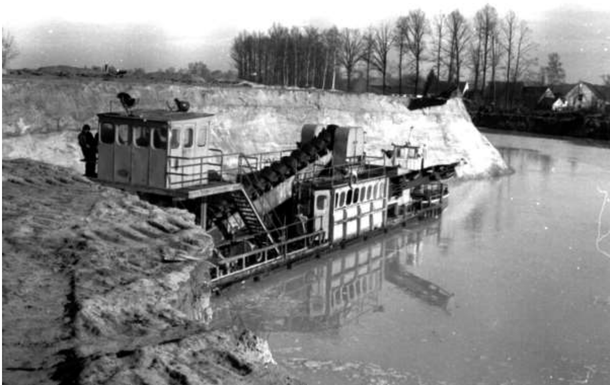
Fotografie č. 47 Historický snímek poskytnutý BS Cost s.r.o. Těžba v jezeře plovoucím korečkovým bagrem v jezeře Horusice (DP Horusice). V pozadí je vidět usedlost u Nohavů, která byla v rámci těžby později zlikvidována. 1977
