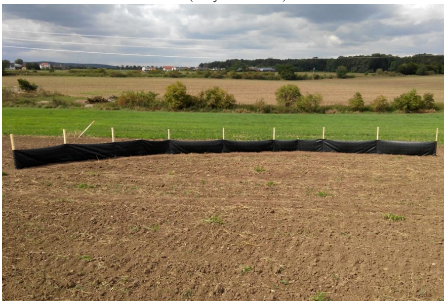
Obr. 1: Protierozní bariéra silt-fence (zdroj: David Kincl)
