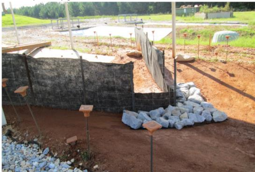
Obr. 8: Uměle vytvořený přeliv na textilií (zdroj: Donald et al., 2016)
