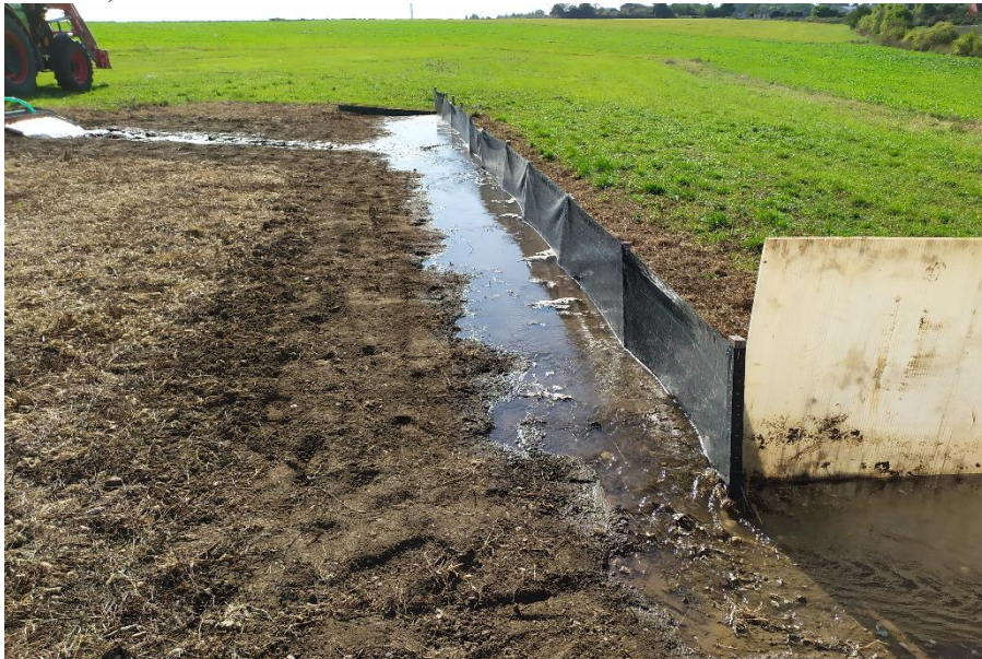
Obr. 17: Směrování povrchového odtoku mobilními protierozními prvky (zdroj: David Kincl)
