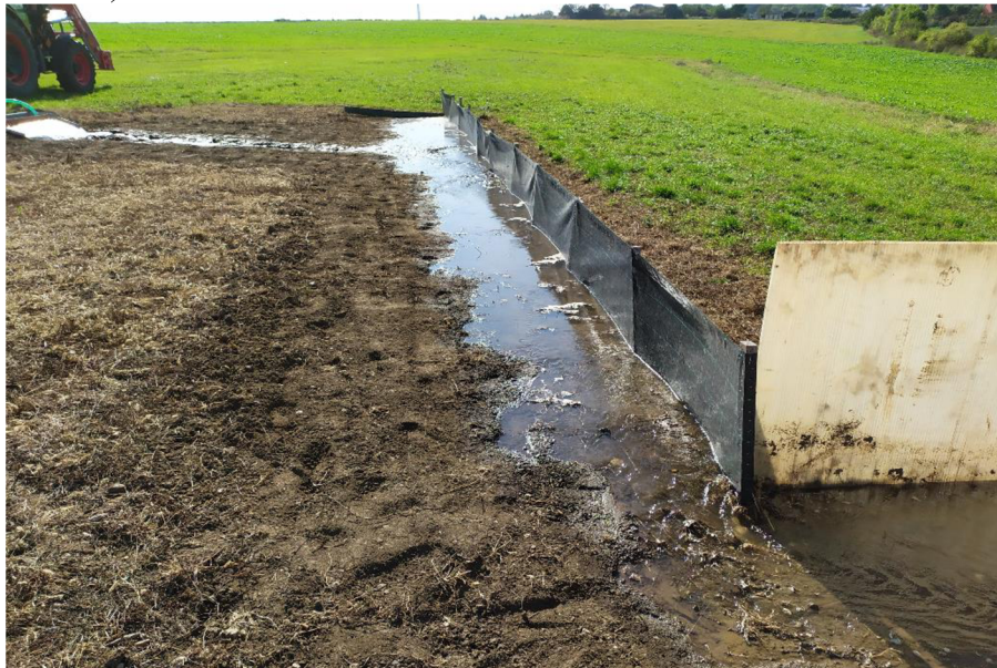
Obr. 17: Směřování povrchového odtoku mobilními protierozními prvky (zdroj: David Kincl)
