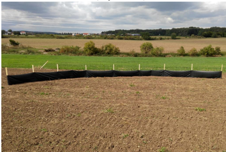
Obr. 1: Protierozní bariéra silt-fence (zdroj: David Kincl)
