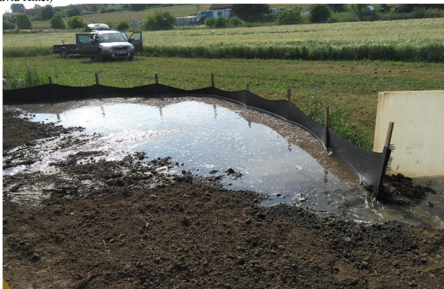
Obr. 9: Boční přeliv bez stabilizace osevem je ohrožen vymíláním rýh a rýžek (zdroj: David Kincl)
