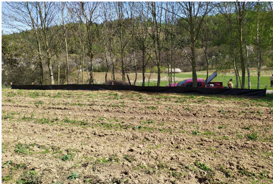
Obr. 15. Protierozní bariéra silt-fence instalovaná do odtokové dráhy (zdroj: David Kincl)
