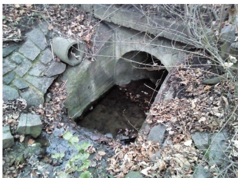
Obr. 26 Zatrubnění toku pod KB 12
