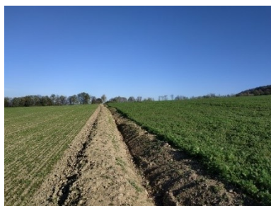
Obr. 39 Nekapacitní záchytný příkop na EHP 6
