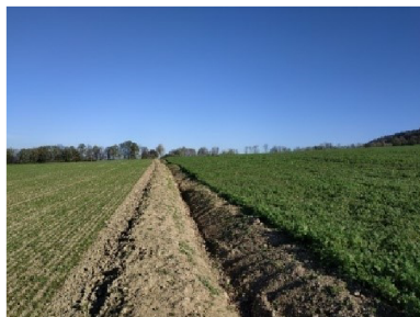
Obr. 39 Nekapacitní záchytný příkop na EHP 6
