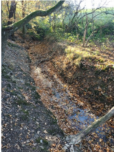
Obr. 54 Stávající napřimené koryto potoku
