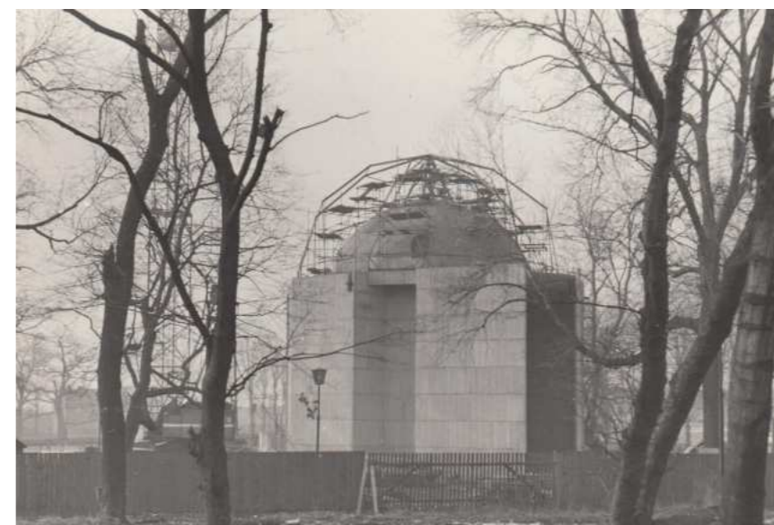
Obr.46 Pavilon při stavbě, zdroj: www.zamek-duchcov.cz
