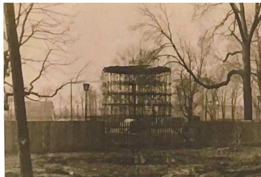
Obr.45 Základy pavilonu, zdroj: Zahrada Olomouc-Státní zámek Duchcov, zahrady a nádvoří, stavebně historický průzkum
