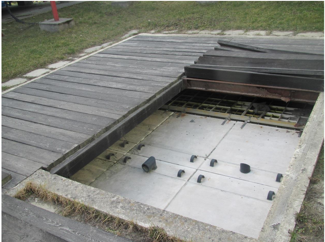
Obr. č. 3 Čistírna odpadních vod Bioreko
