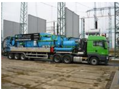
Obr. č. 16 Mobilní čištění odpadních vod
