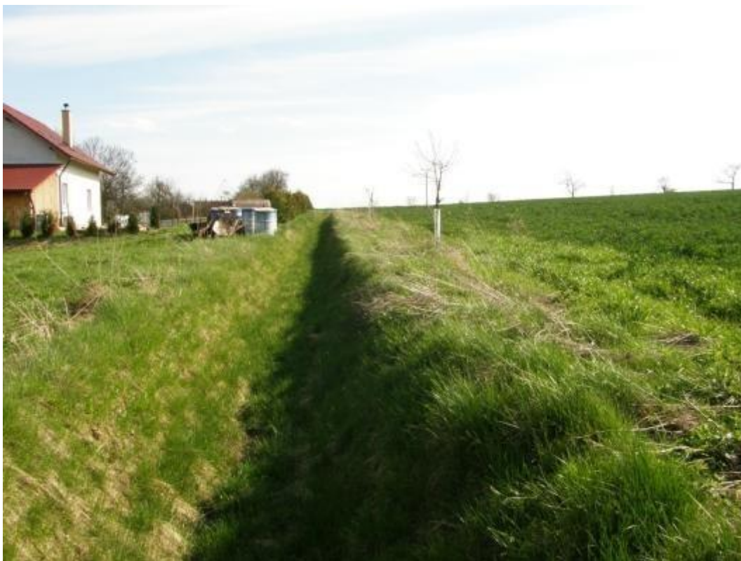
obr. 8. Protierozní příkop záchytný (Encyklopedie vúmop.cz).
