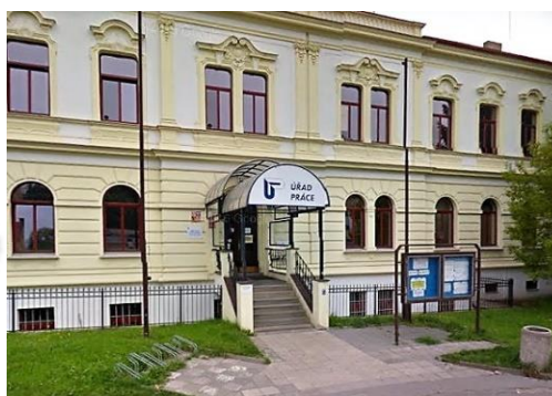
Obrázek 5: Úřad práce v Kladně
