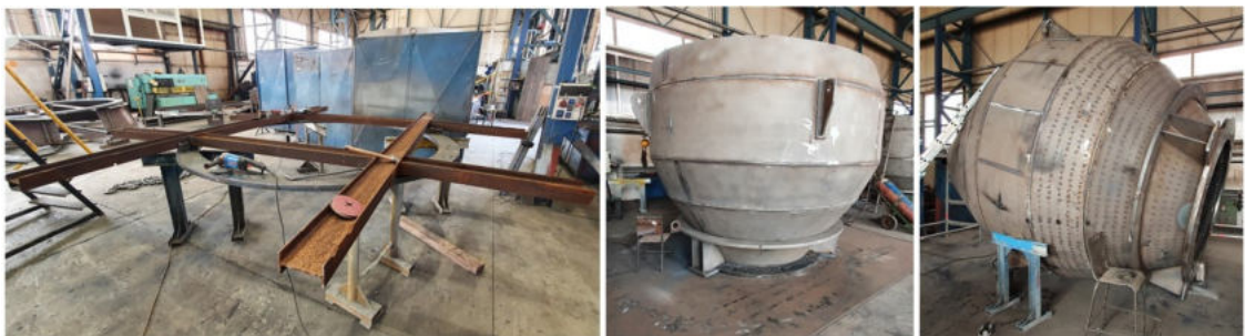
Obr. 24 Montáž upevňovacího systému
