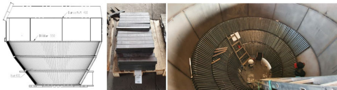
Obr. 25 Montáž opláštění z ořezvzdorné oceli
