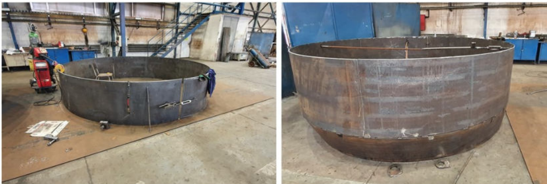
Obr. 21 Platforma a ustavení prvního segmentu pláště
