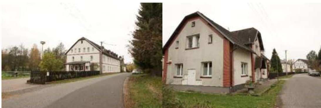
Obr. 20: Domov pro osoby se zdravotním postižením – hlavní budova, Obr. 21: Domov pro osoby se zdravotním postižením – vedlejší budova
