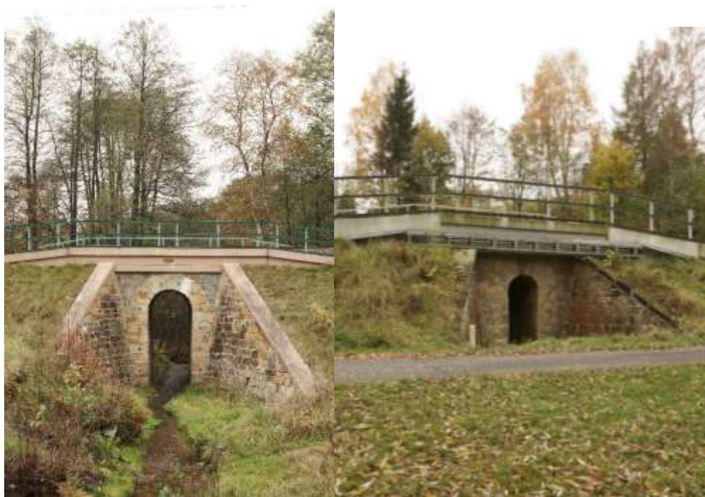
Obr. 43: Opravený mostek po povodních, Obr. 44: Opravený mostek po povodních
