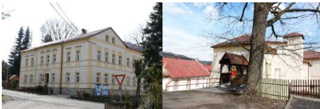
Obr. 63: Multifunkční dům – přední pohled, Obr. 64: Multifunkční dům – pohled zezadu
