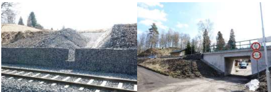
Obr. 51: Zrekonstruovaná železniční trať včetně zpevnění svahu pomocí gabionu, Obr. 52: Zrekonstruovaný most a v pozadí zrekonstruované nádraží
