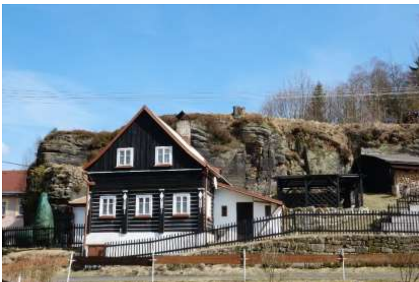
Obr. 6: Stavba zapadající do architektonického rázu Kytlic
