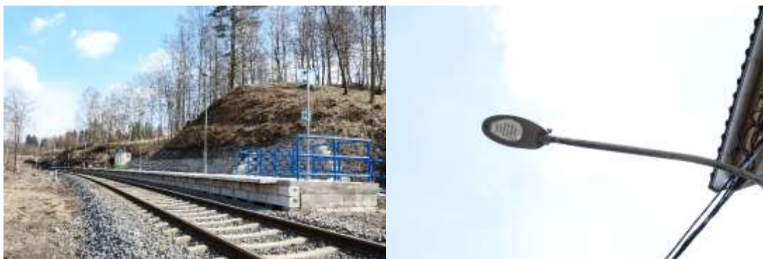
Obr. 53: Zrekonstruované vlakové nádraží, Obr 54: Nové „ledkové“ veřejné osvětlení
