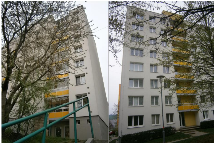
Obr. 52 Pohled na část bytového domu (vlevo jižní pohled, vpravo severní pohled)
