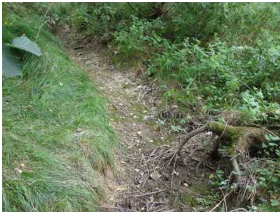
Obr. 10 Zcela vyschlé koryto potoka před vybudováním hrázky (B. Janíčková, 8. 8. 2008)
