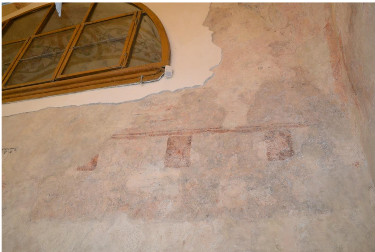
Obr. 26/ Fragments architektury, 70. léta 13. století, nástěnná malba, Hrozová, kostel svatého archanděla Michaela, severní stěna chóru.
