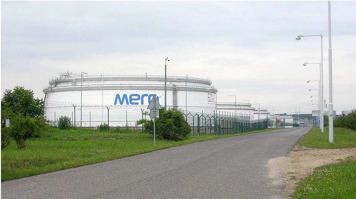
Obr. 1.3 Skladovací zásobník ropy (Nelahozeves)
