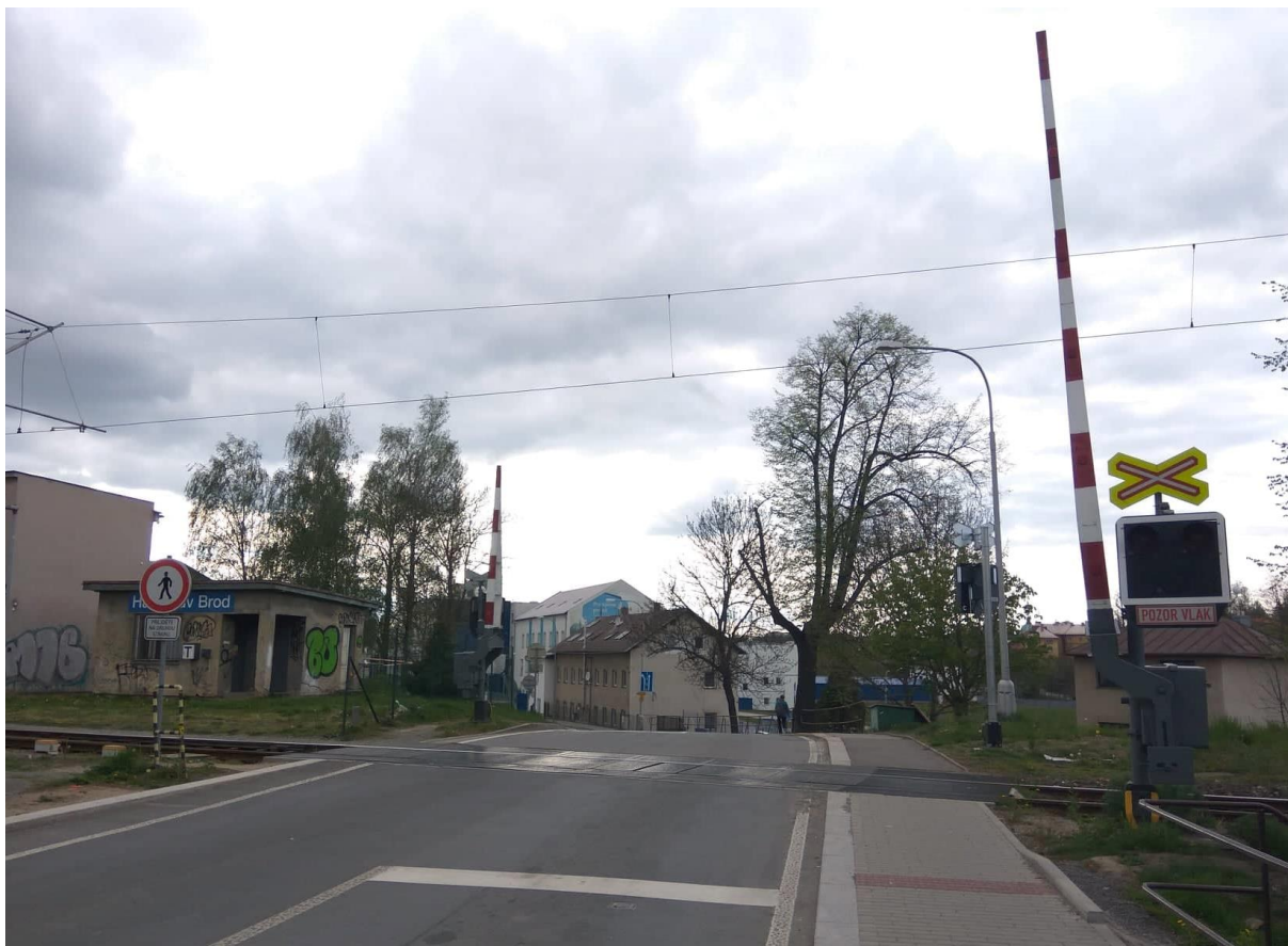
Obrázek 6 – Přejezdové zabezpečovací zařízení světelné s mechanickou závorou [23]
