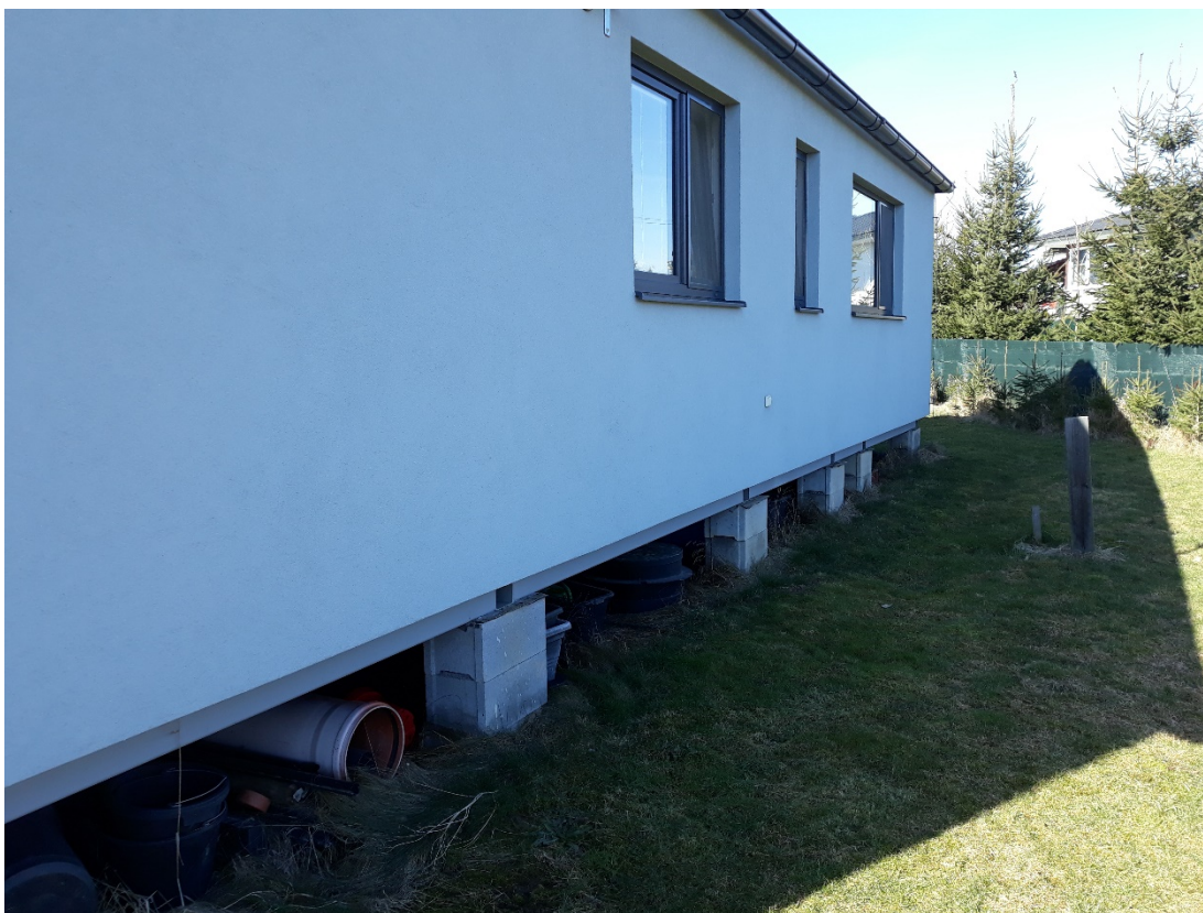
Obrázek 9: Dům č. 49 umístěný na betonových patkách
