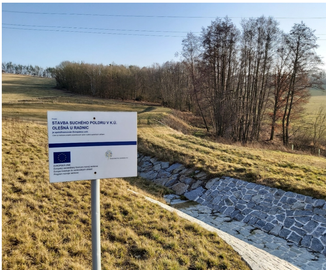
Obrázek 5: Suchý poldr-protipovodňové opatření nad obcí Olešná
