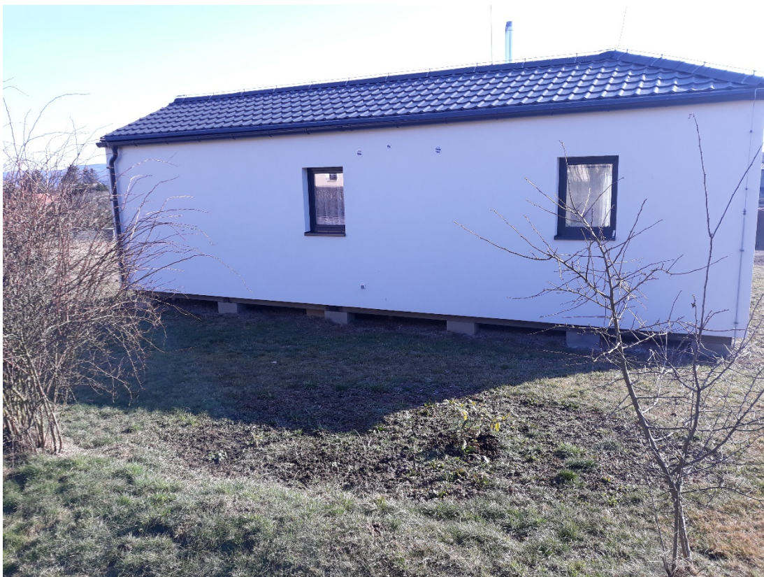
Obrázek 12: Dům č. 49 umístěný na betonových patkách
