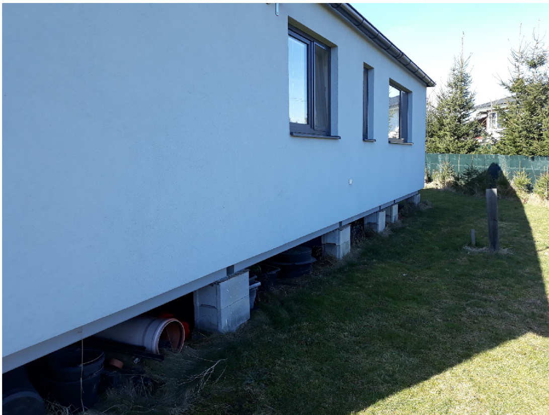
Obrázek 9: Dům č. 49 umístěný na betonových patkách
