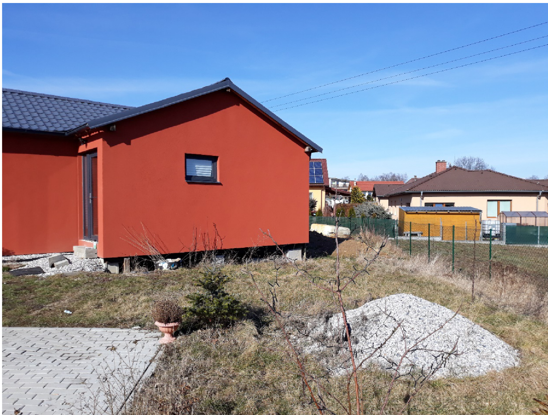
Obrázek 10: Dům č. 54 umístěný na betonových patkách a částečně zasypaný zeminou
