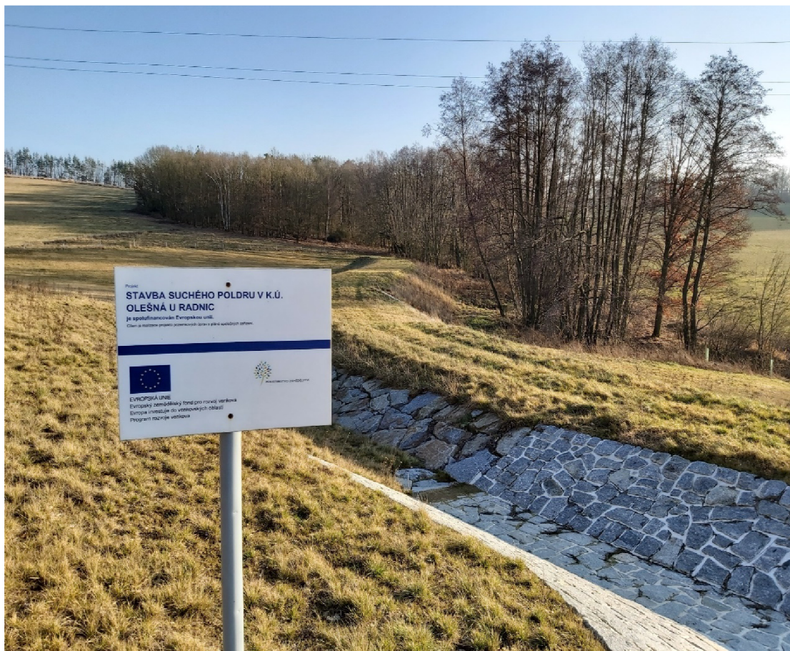
Obrázek 5: Suchý poldr-protipovodňové opatření nad obcí Olešná
