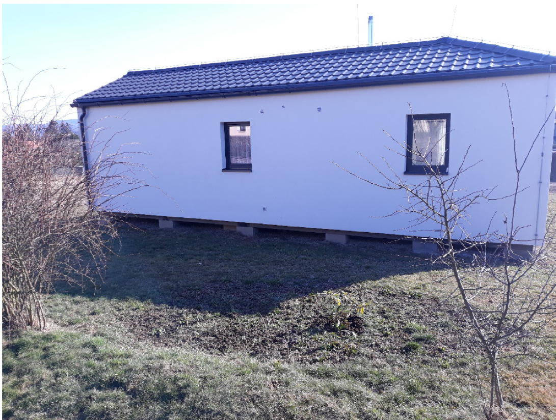
Obrázek 12: Dům č. 49 umístěný na betonových patkách
