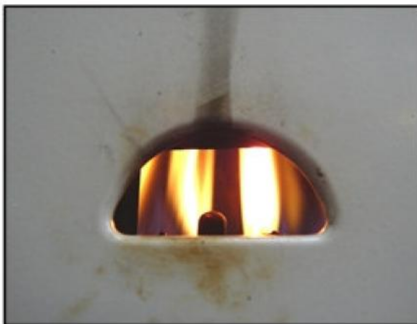
Obr. 8: Svítivý plamen nedokonalého spalování. Zdroj: www.tzb-info.cz
