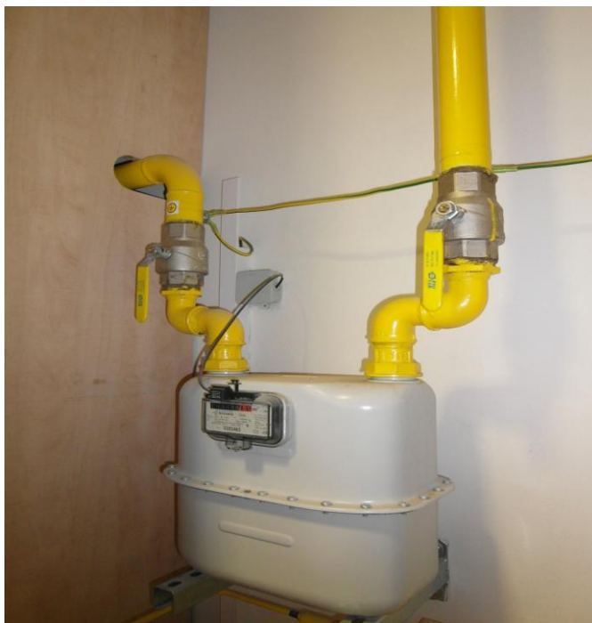
Příloha A: Hlavní uzávěr kotelny.
