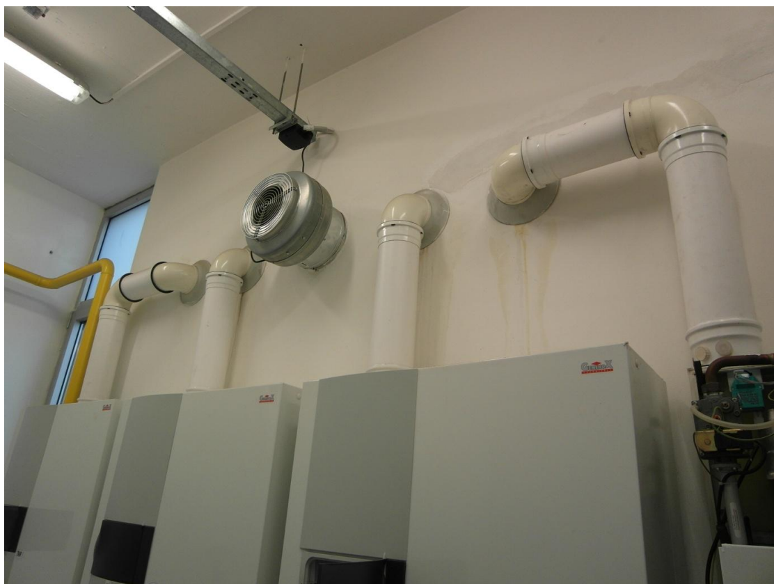
Příloha D: Odvedení spalin z kotlových jednotek.
