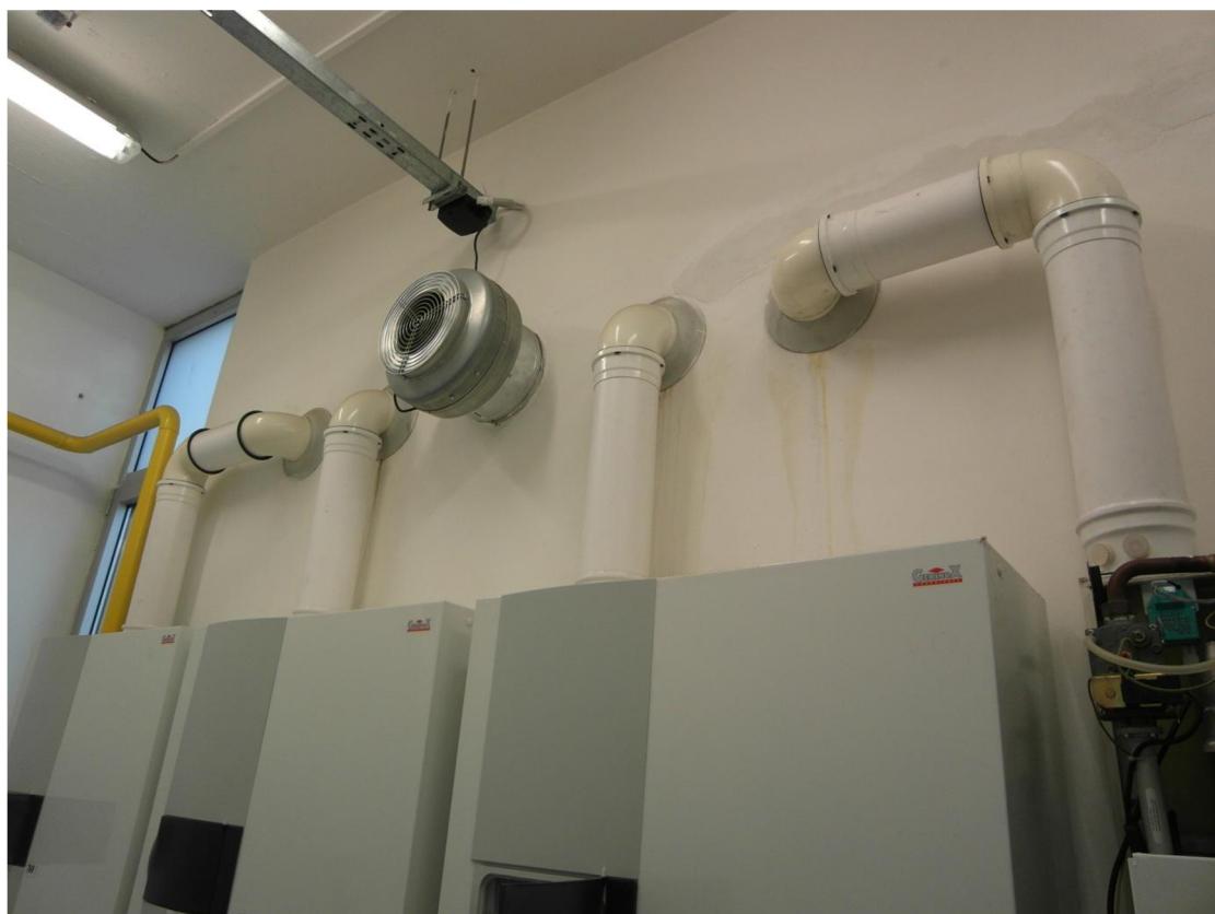
Příloha D: Odvedení spalin z kotlových jednotek.
