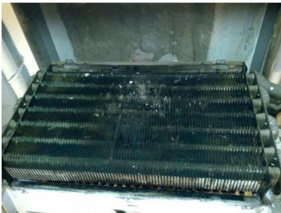
Obr. 9: Příklad zaneseného výměníku. Zdroj: http://servisplynospotrebicu.webnode.cz
