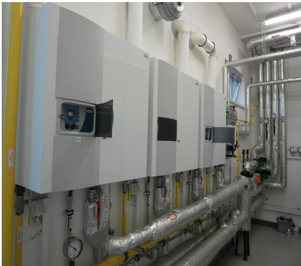
Příloha B: Plynová kotelna, čtyři závěsné kotle Geminox THRi 10-50.
