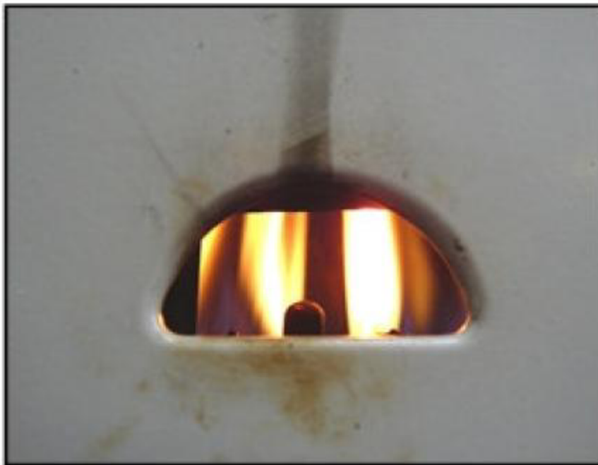
Obr. 8: Svítivý plamen nedokonalého spalování. Zdroj: www.tzb-info.cz
