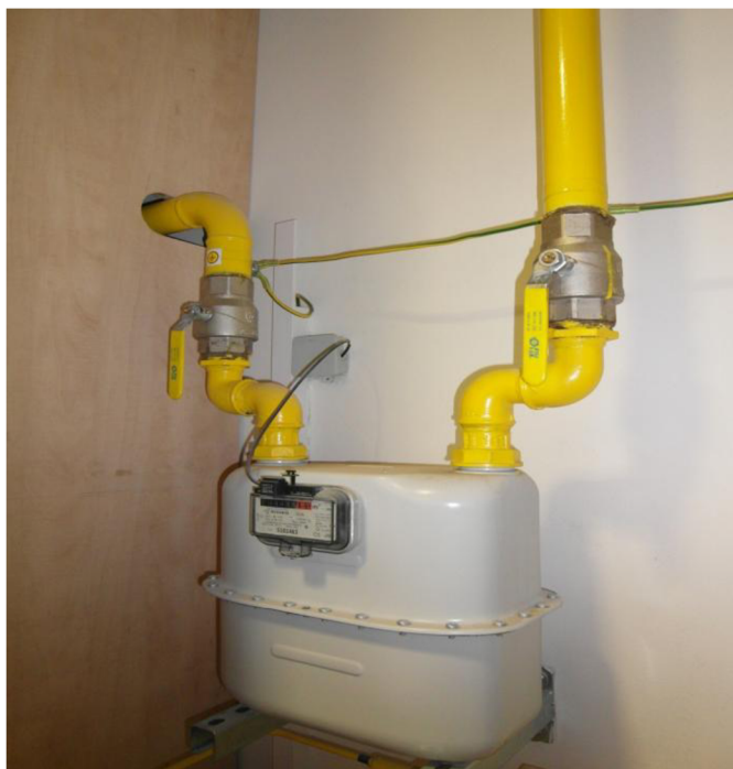
Příloha A: Hlavní uzávěr kotelny.
