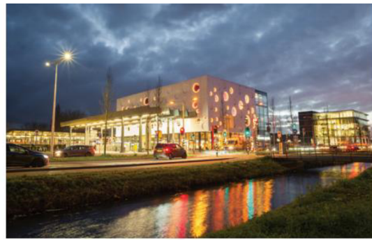
Obchodní centrum a kancelářské budovy
