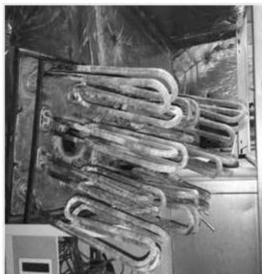
Obr. 10 - zanesení varných tyčí [17]
