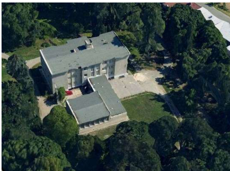
Obr. 12 - Situační pohled (pohled z jihozápadu) - stávající stav [24]
