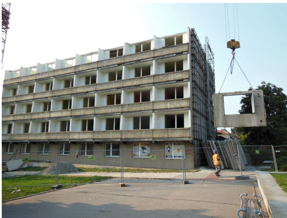
Obr. 22 Dekonstrukce objektu hotelu Dukla v Blansku: Transport panelu při využití metody shora-dolů (top-down) (Záboj 2015)
