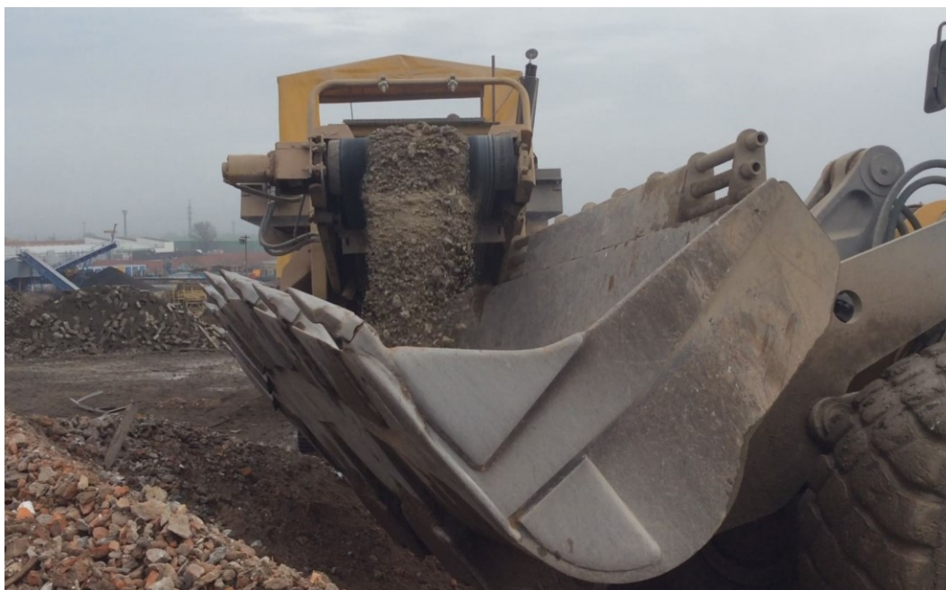
Obr. 27 Průběh drcení na frakci 0–63 mm v areálu recyklačního střediska Moravostav a.s. v Brně
