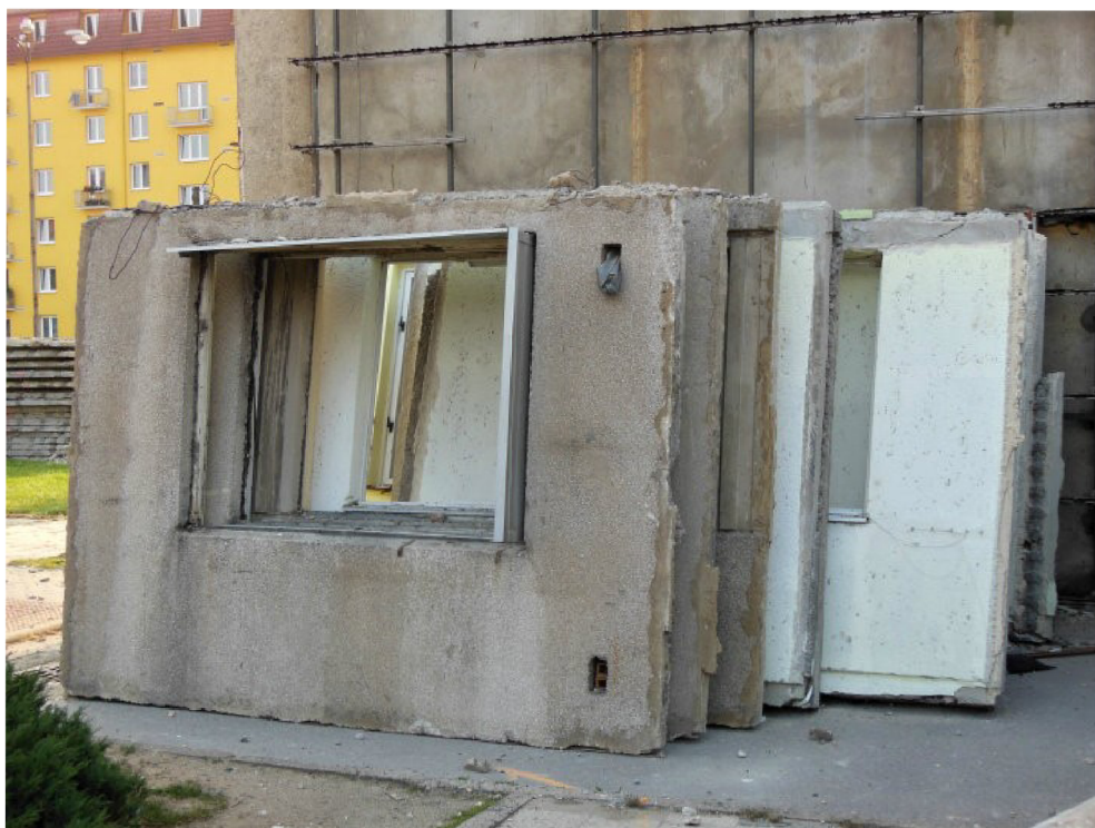
Obr. 23 Dekonstrukce objektu hotelu Dukla v Blansku: Demontované a odstrojené obvodové a vnitřní stěnové panely určené k separaci (Záboj 2015)
