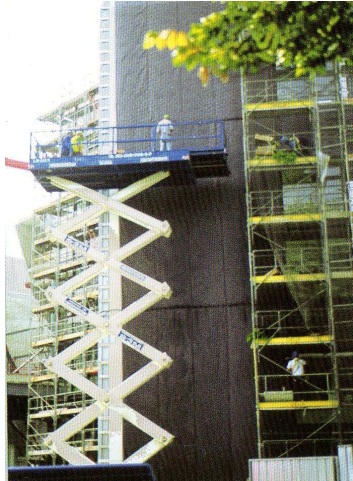
Obrázek 17: Montáž textilního systému (Blanc, 2012)
