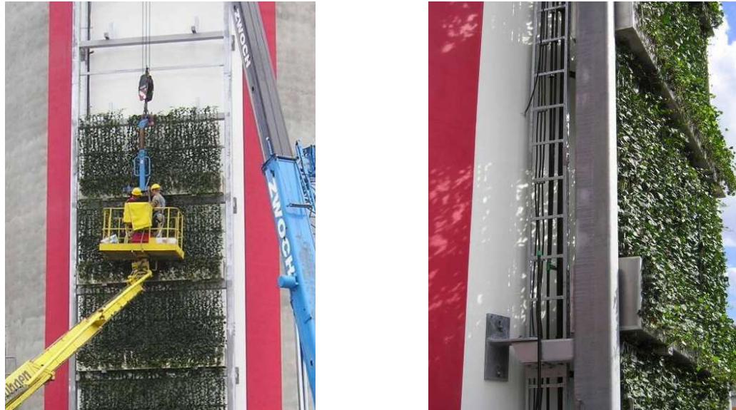
Obrázek 12: Montáž a detail systému Elata (Helix – Pflanzensysteme)
