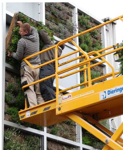
Obrázek 15: Montáž předpěstovaných košů do připravené konstrukce (Helix – Pflanzensysteme).
