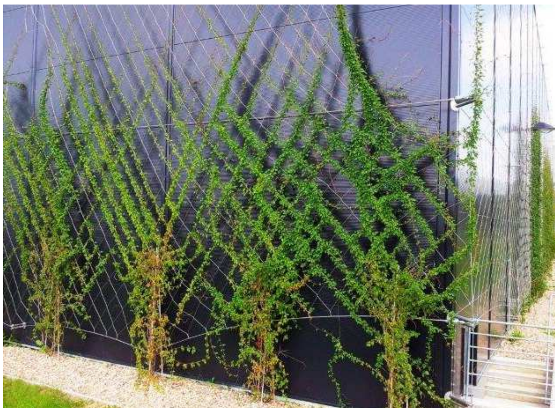
Obrázek 11: Ocelová síť s pnoucí rostlinou, skladová hala v Komorovicích u Humpolce (Louda,Cabletech).
