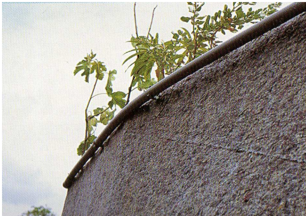
Obrázek 19: Závlažovací hadice na vrcholu konstrukce (Blanc, 2012)
