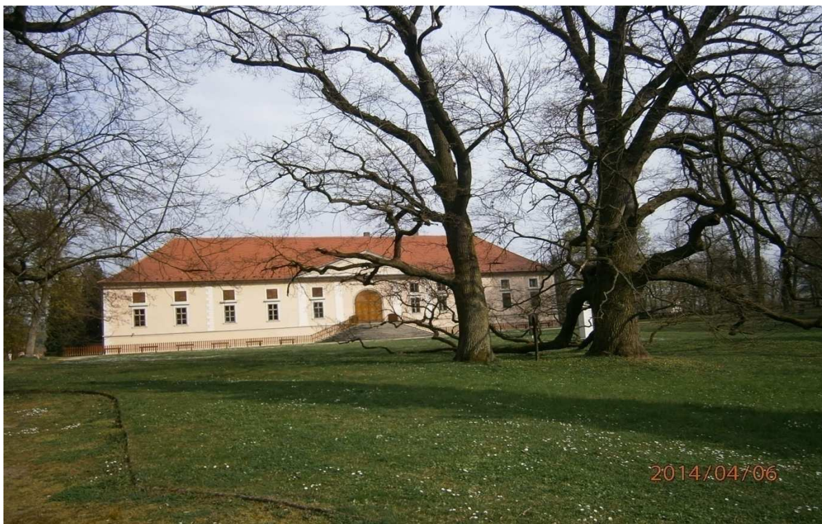
Obr. 10.13: Pohled na západní průčelí zámku s okrouhlým schodištěm s památnými Štěkeňskými duby v jeho popředí.
