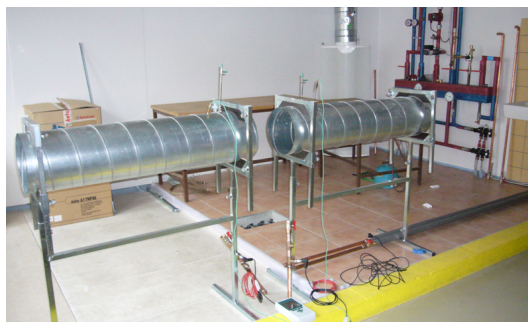
Obr. B.1: Počáteční práce na měřicím úseku.
