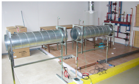
Obr. B.1: Počáteční práce na měřícím úseku.
