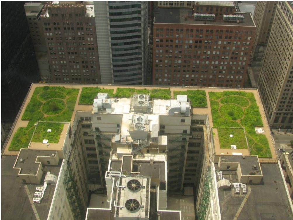
Obr. 12: Pohled na střešní vegetaci neboli zelenou střechu.
