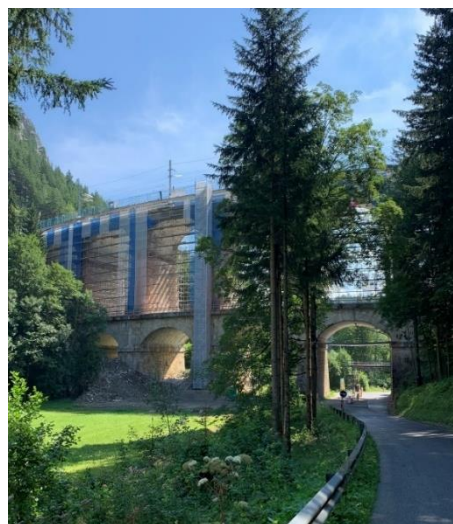
Abb. 7 Viadukt Kalte Rinne
