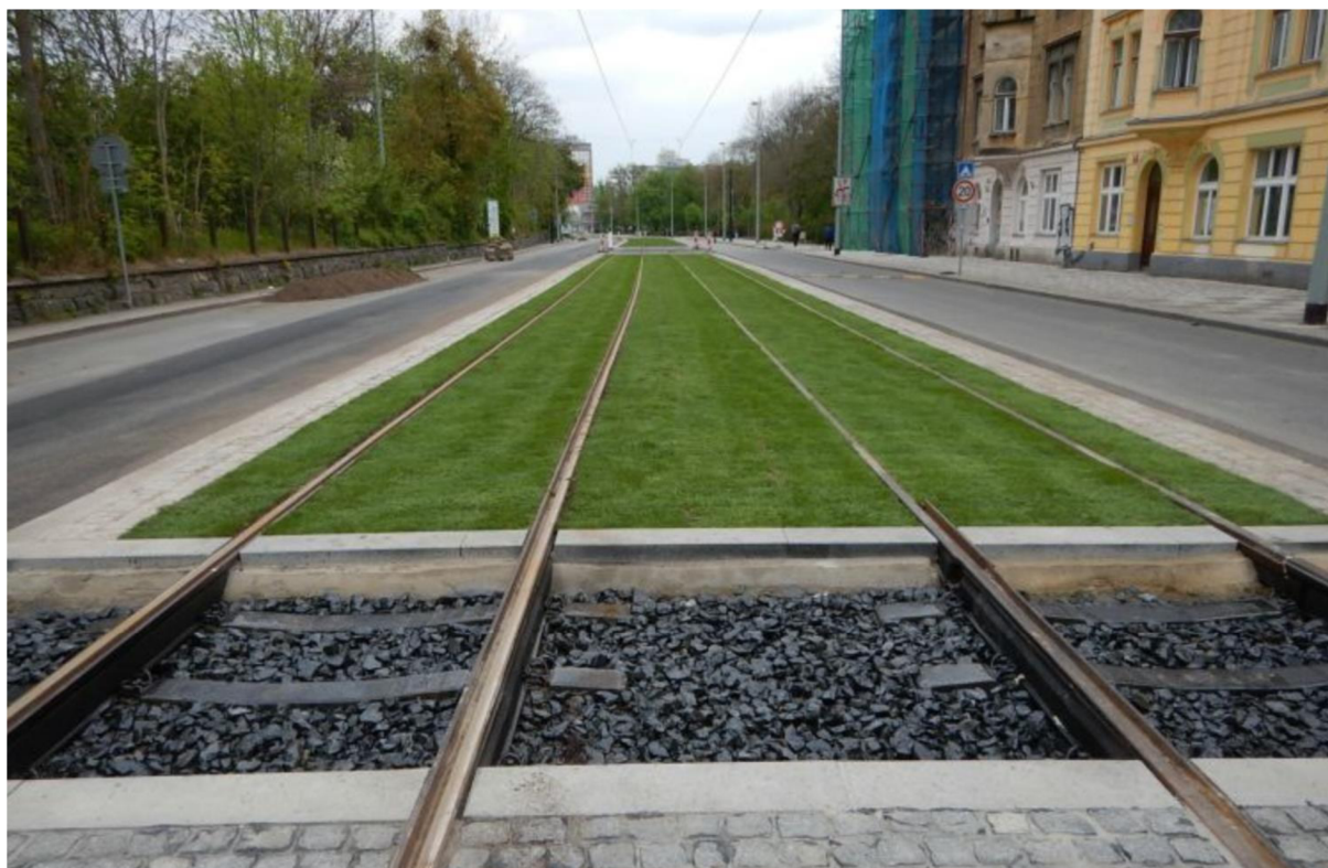
Obrázek 12: Zatrávněné tramvajové pásy (ALSTAP s.r.o. 2021).
