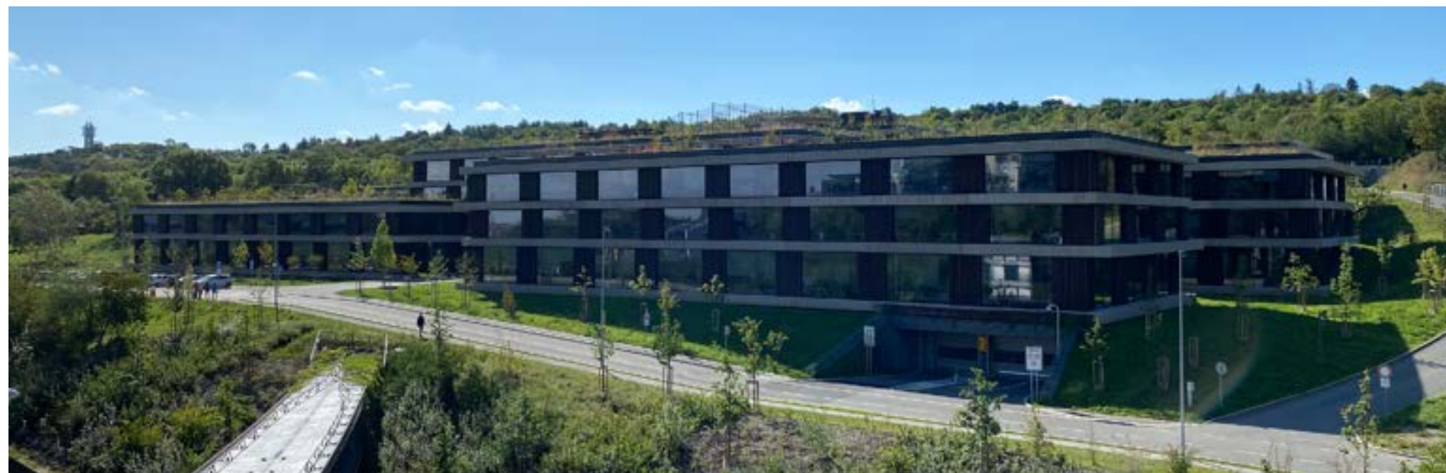
obr. 4 Pohled na novou budovu SHQ ČSOB
