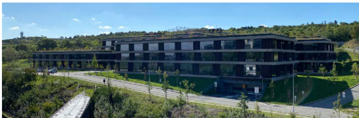
obráz. 4 Pohled na novou budovu SHQ ČSOB
