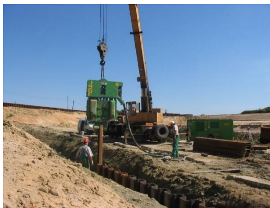
Obr. č. 37 Realizace beranění záporového pažení [19]
