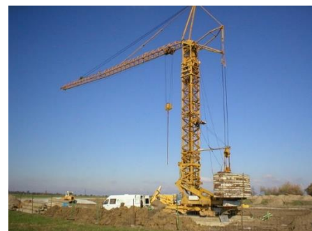
Obr. č. 46 Věžový jeřáb [25]
