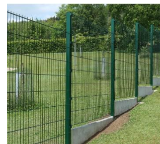
Obr. č. 30 Staveništní oplocení [11]
