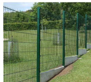
Obr. č. 30 Staveništní oplocení [11]
