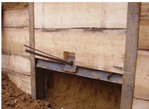
Obr. č. 80 Zapuštěná převázka [53]
