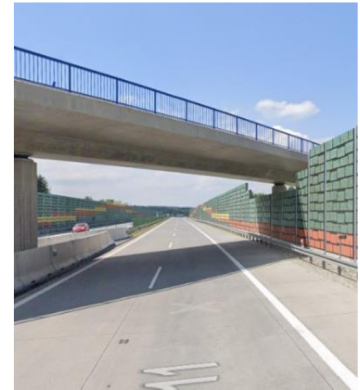
Obr. č. 17 Podjezd mostu v Bystřici – Reálný pohled [2]
