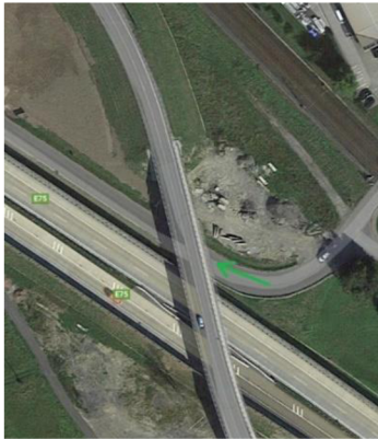
Obr. č. 18 Podjezd mostu v Bystřici – Pohled shora [2]
