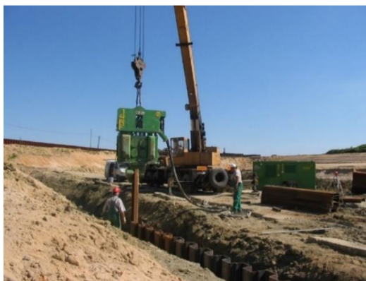
Obr. č. 77 Realizace zápor [19]
