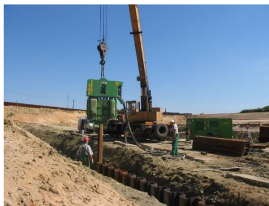
Obr. č. 37 Realizace beranění záporového pažení [19]
