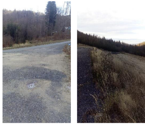
Obr. č. 22 Místní šetření [3]
