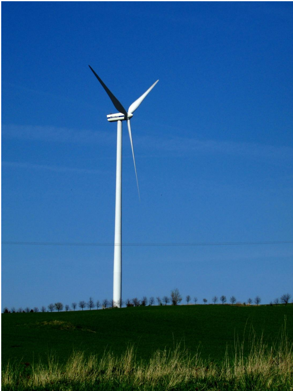
Obrázek 10 Větrná elektrárna Maletín (zdroj dat: vlastní foto, 2018)
