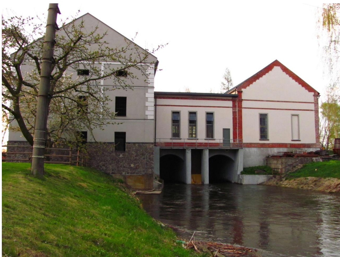
Obrázek 8 Malá vodní elektrárna v Mohelnici (zdroj dat: vlastní foto, 2018)
