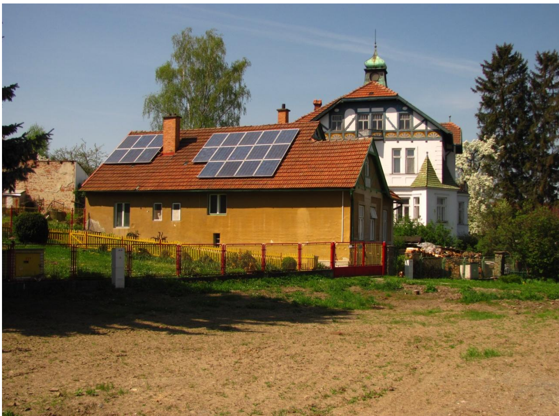
Obrázek 19 Příklad vhodného umístění na střeše rodinného domu v obci Loštice, název provozovny FVE - Havlíček (zdroj dat: vlastní foto, 2018)
