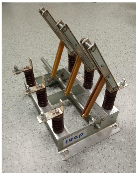
Obr. 17 - Analyzovaný odpojovač QAK
