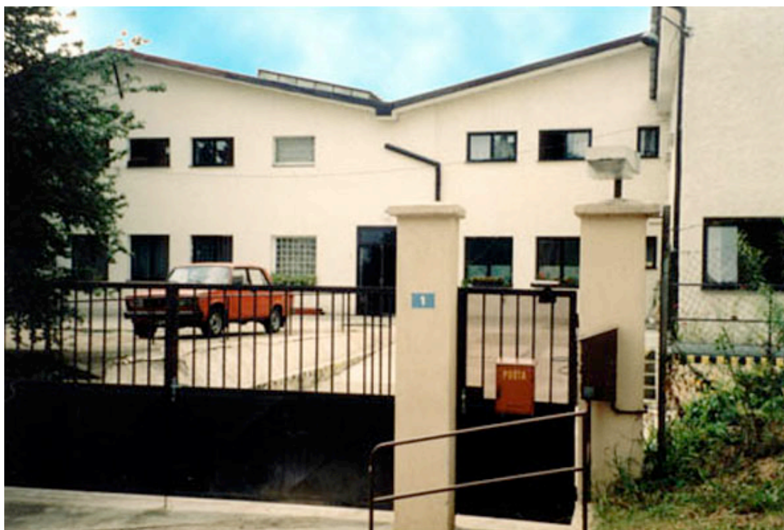
Budova praktického vyučování, Praha 5 - Nový Zlíčov
