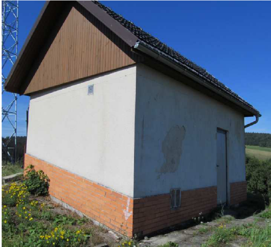
Obr. 3.16 Vstup do VDJ
