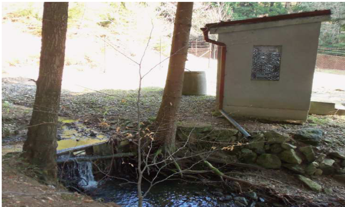
Obr. 3.4 Zvyšování hladiny podzemní vody
