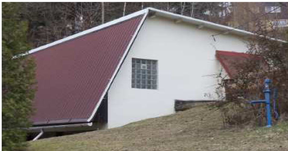
Obr. 3.10 Úpravna vody Kateřinice
